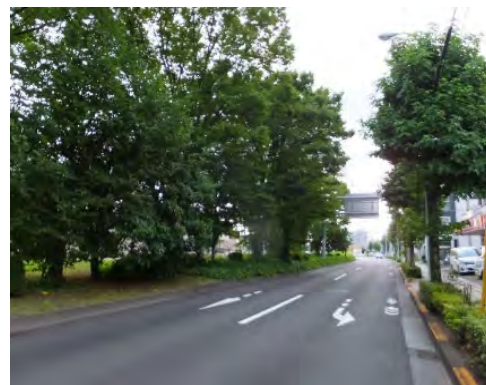
下り線 (車道幅員 7.5m)
