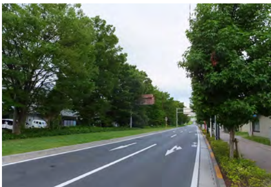
上り線 (車道幅員 7.3m)
