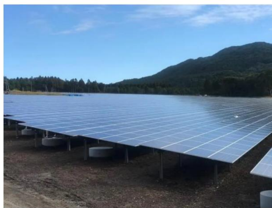
鹿児島県にある大規模太陽光発電所。2022 年 7 月の大雨で土砂崩れを誘発した。©株式会社エフォート
