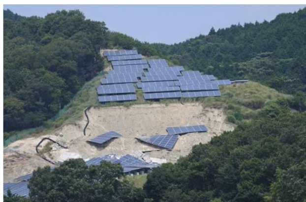
兵庫県にある太陽光発電所。2018 年 7 月の西日本豪雨で崩落事故を起こした。 ©日経 BP
