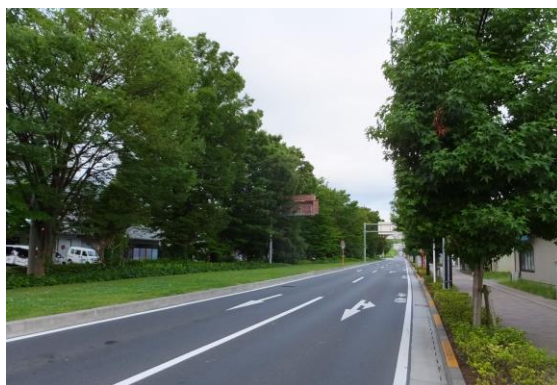
上り線 (車道幅員 7.3m)
