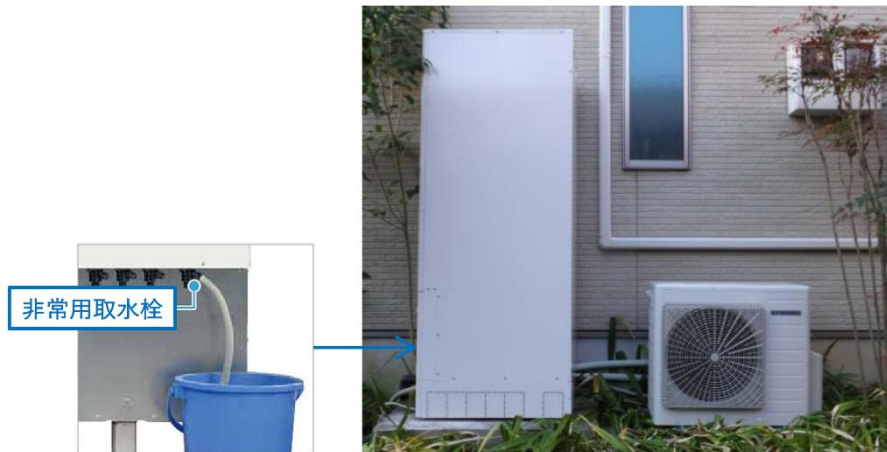
家庭用ヒートポンプ給湯機 貯湯タンク（左）ヒートポンプユニット（右）
