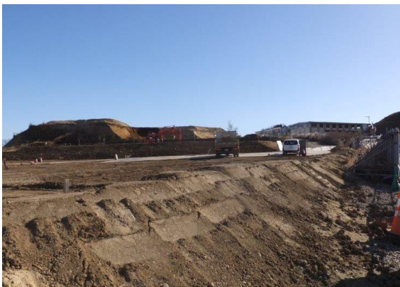
宅地造成の状況（右奥に見えるのが南山小学校）
