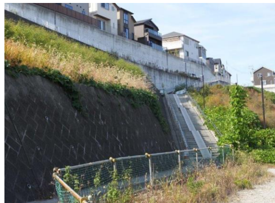
宅地造成・住宅建設完了後の状況
