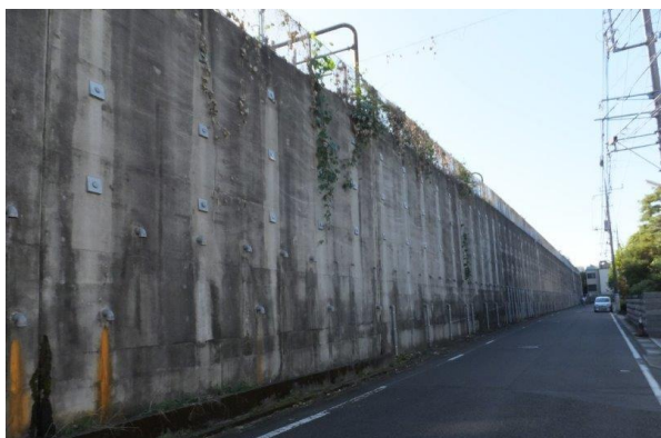
急傾斜地に建設された鉄道の駅。巨大な擁壁が軌道と駅舎を支える。京王よみうりランド駅。
