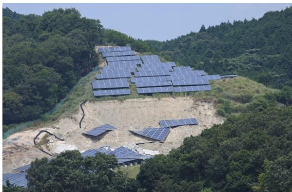
兵庫県内の傾斜地を開発して建設された太陽光発電所。2018年7月の西日本豪雨で崩落事故を起こした。©日経BP
