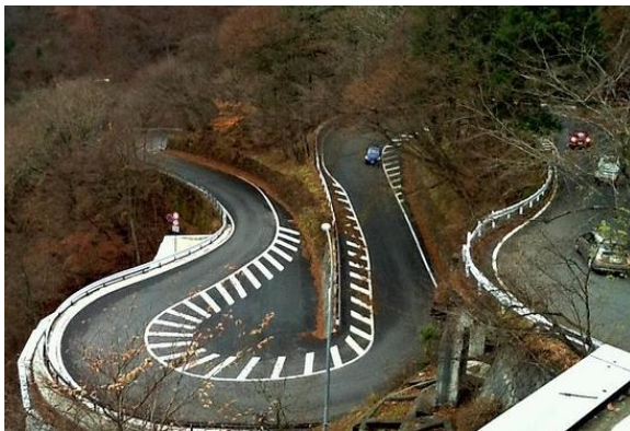
急傾斜地に建設された道路の例。折れ曲がる道路の延長は長く、建設のコストと環境負荷は大きくなる。日光いろは坂。
